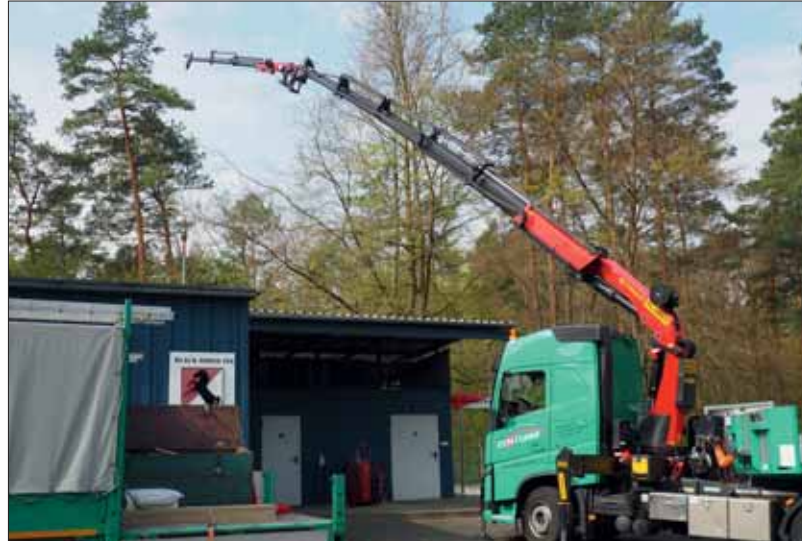
Der Lagercontainer wird vom Kran in Stellung gebracht.
