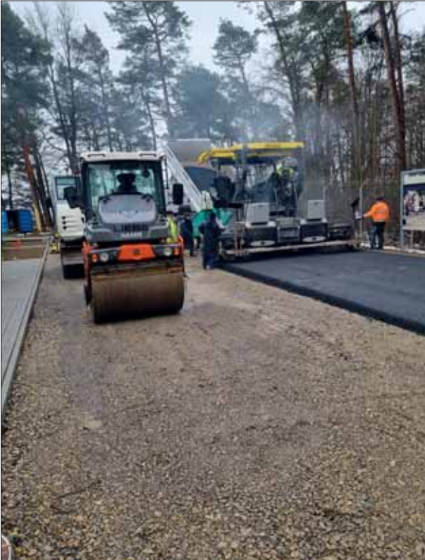
Das Basketballfeld wird planiert und geteert.
