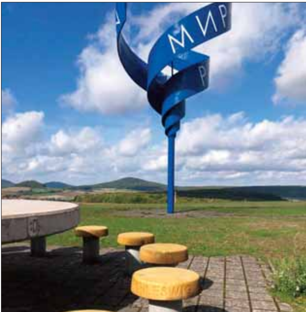
Die Friedensspirale wurde saniert und die Sitze um den Runden Tisch erneuert.
